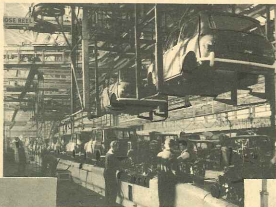
T. v. synes den geniala tvärmotorn i 850 som har växellåda och slutväxel i ett block med motorn. Bilden ovan visar 850-an i massproduktion vid BMC:s fabriker i England och bilden t. h. den enkla och ur servicesynpunkt geniala uppbyggnaden av 850-an.
